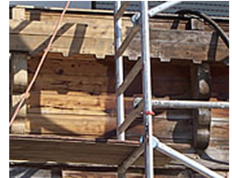
Sanierung von Holz
